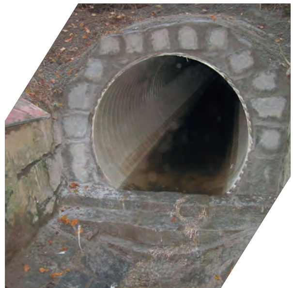
Sanierte Bachverrohrung
