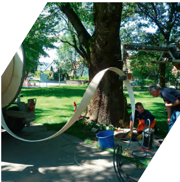
Einzug des Wickelprofils
