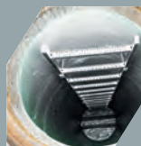
Schacht- und Großprofilanierung
