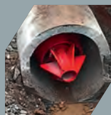
Kurz- und Langrohrlining
