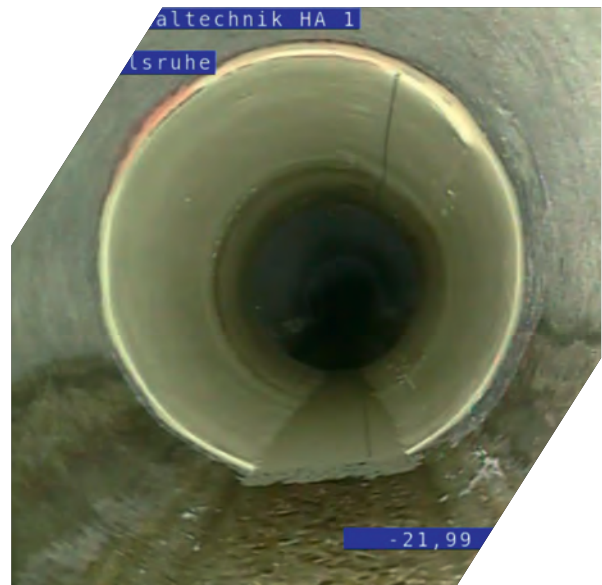
Läuft wieder: erfolgreich ausgeführte Reparatur
