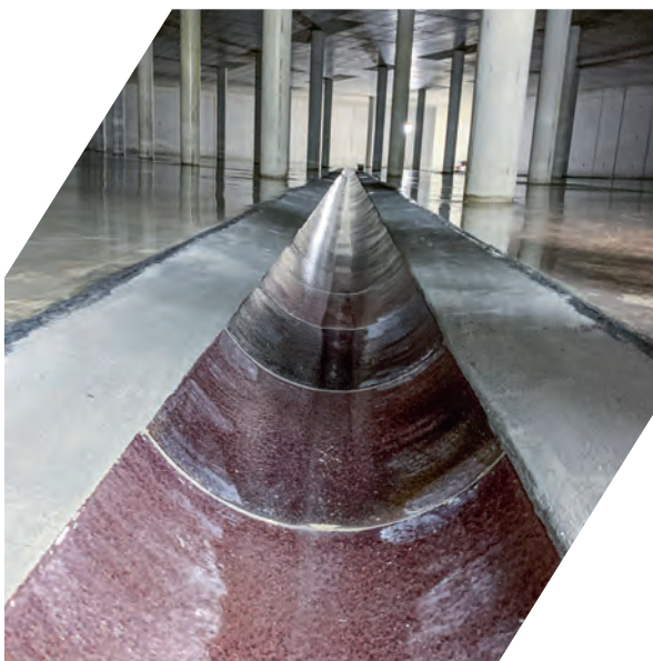
Sanierung eines Regenrückhaltebeckens
