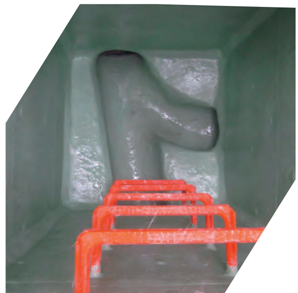
Schacht nach der Sanierung
