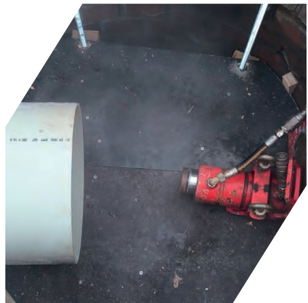
Bereit zum Einschub: neues Rohr im Schacht
