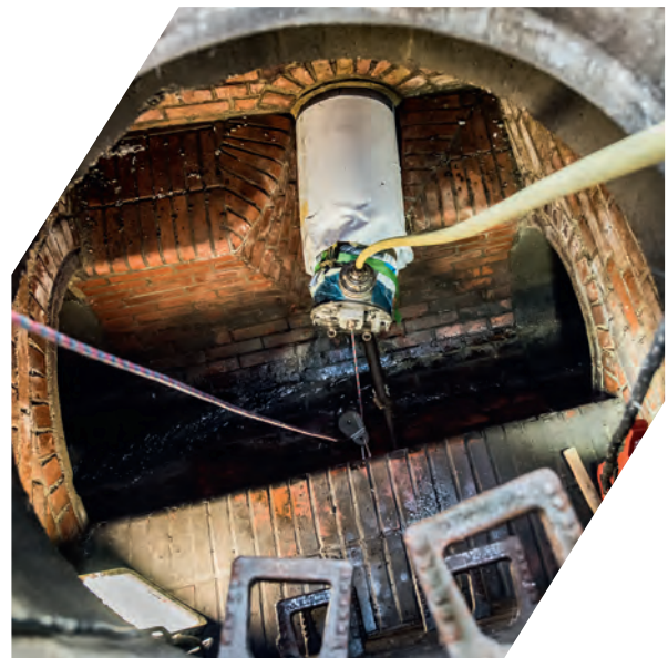
Liner-Ende im Schacht
