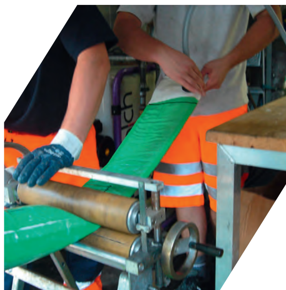
Tränkung des Schlauchs mit Harz
