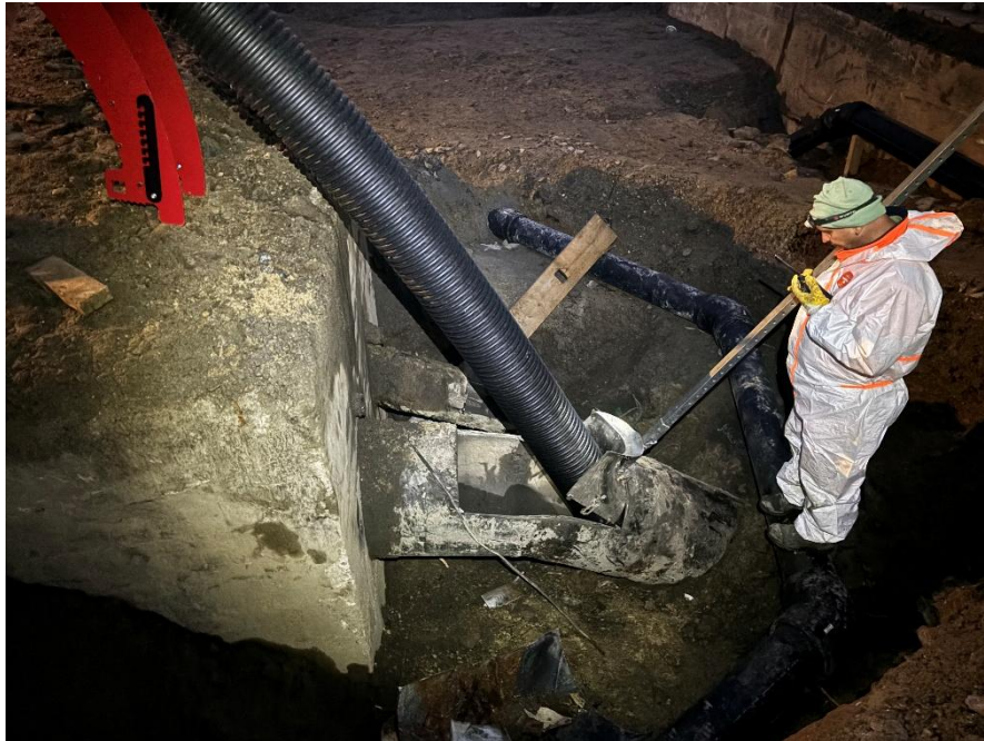
Einziehvorgang © Geiger Kanalsanierung
