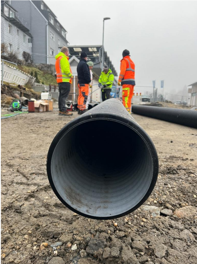
Schweißen des Rohrstranges
