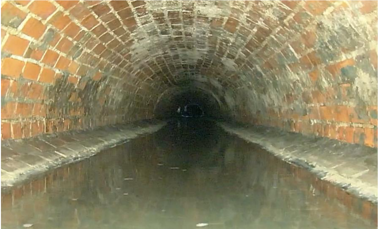
Die Haltung vor der Renovierung © Geiger Kanalsanierung
