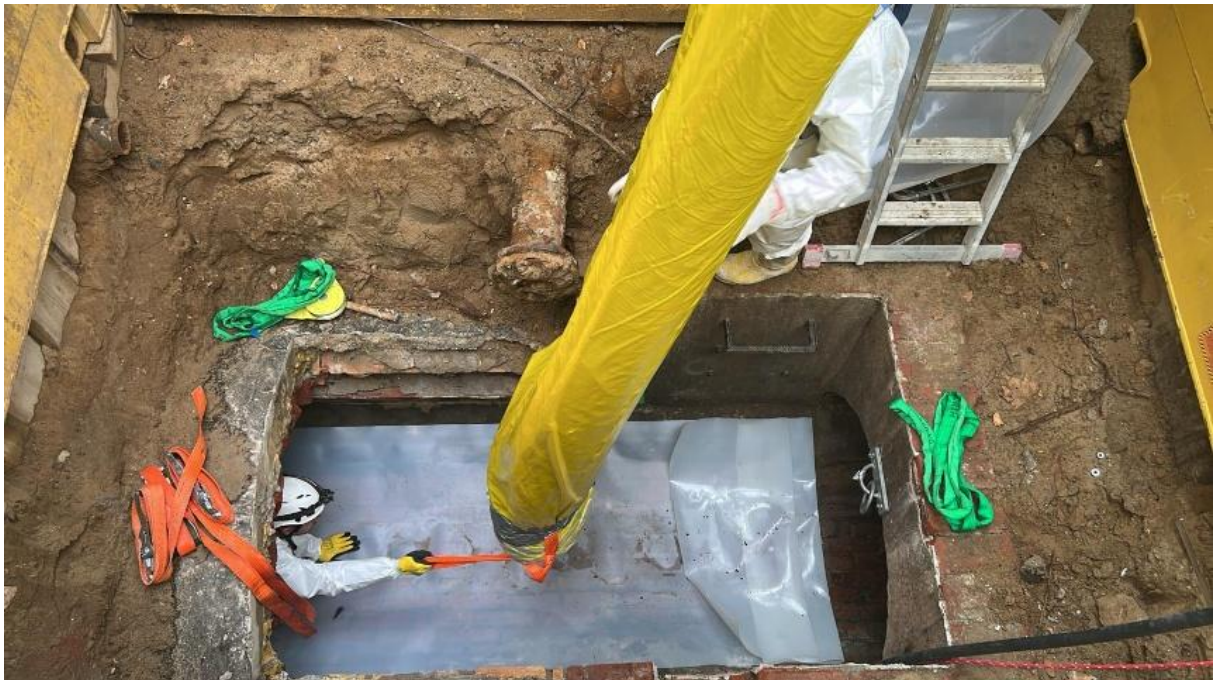
Linereinzug © Geiger Kanalsanierung
