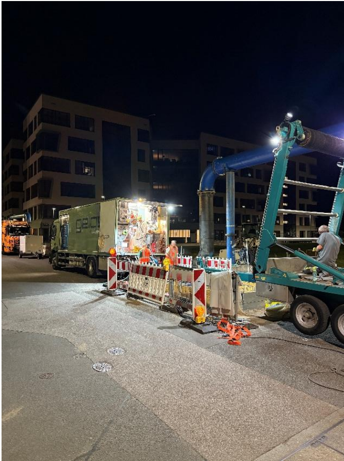
Die Baustelle bei Nacht
