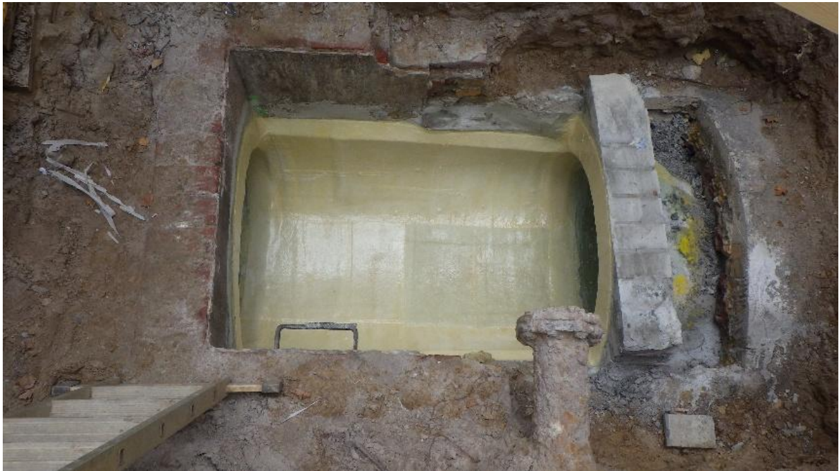
Der sanierte Schacht © Geiger Kanalsanierung
