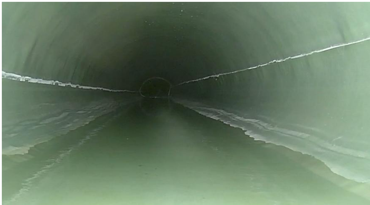
Die renovierte Haltung © Geiger Kanalsanierung
