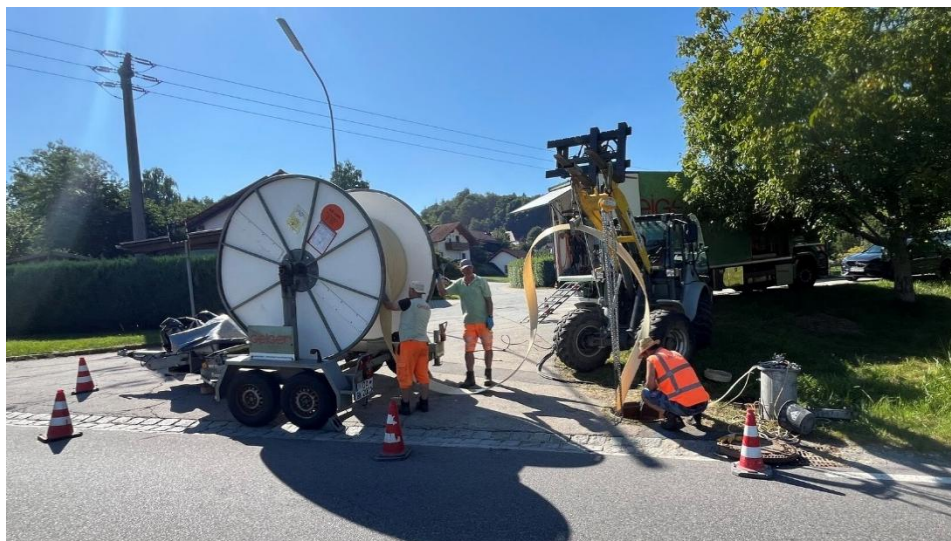
Sanierung mittels Wickelrohrverfahren
