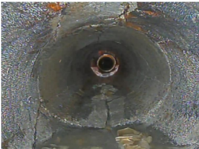
Das verformte Rohr vor der Sanierung
