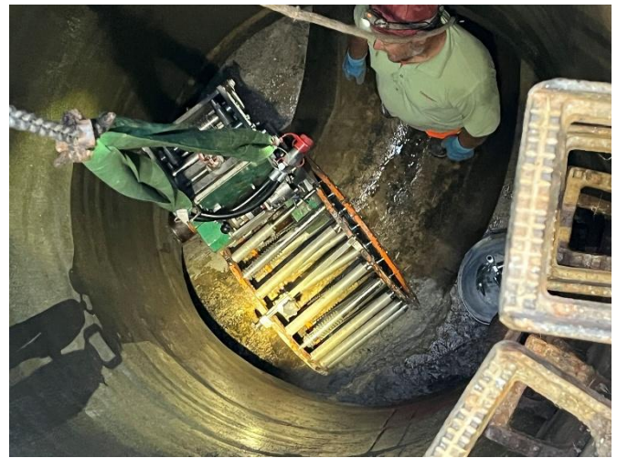
Einsetzen des Wickelkorbs in den Kanal
