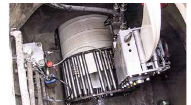
Wickelmaschine im Schacht
