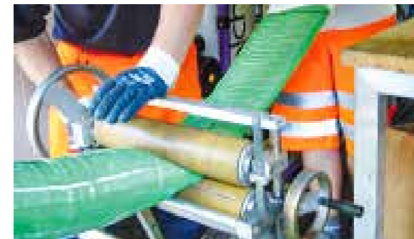
Tränkung des Schlauchs mit Harz
