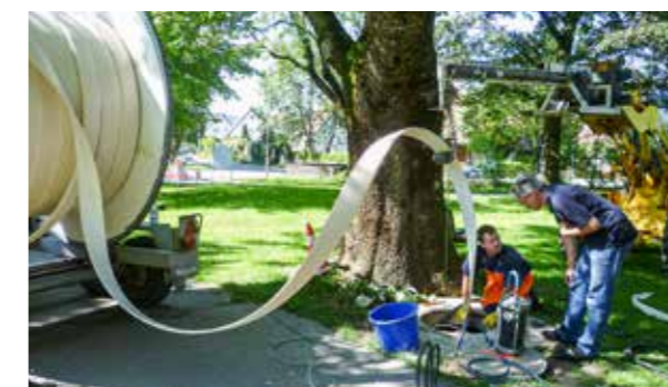
Einzug des Wickelprofils
