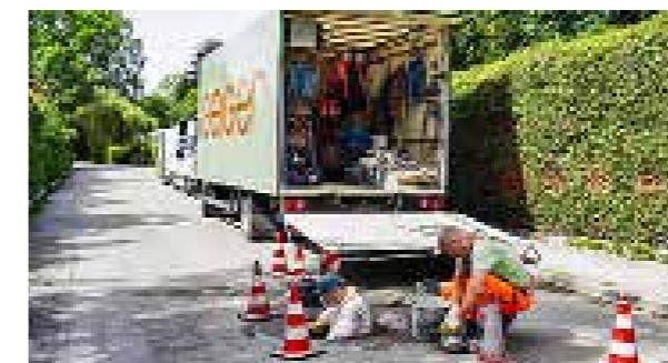
Handsanierungskolonne im Einsatz
