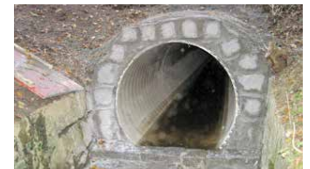
Sanierung eines alten Wellstahldurchlasses
