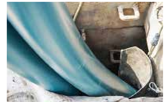
Linereinzug über den Schacht
