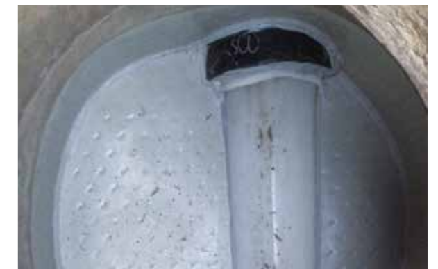
Nach der CP-Sanierung
