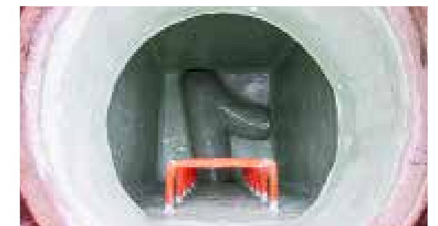
Schacht nach der Sanierung
