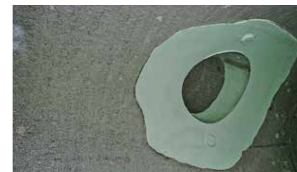
Sanierter Stutzen
