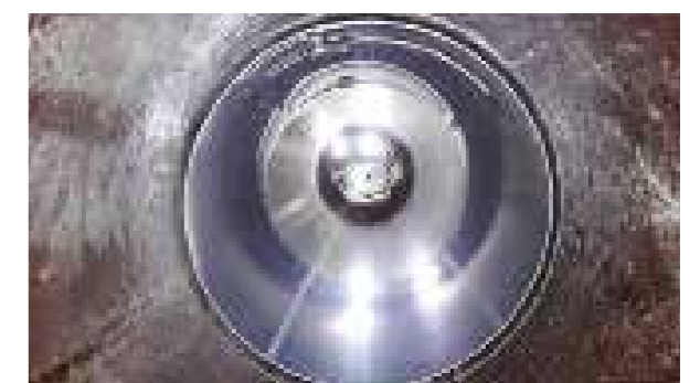
Edelstahlmanschette im eingebauten Zustand
