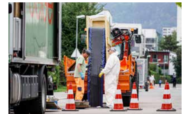
Einbau des Schlauchliners
